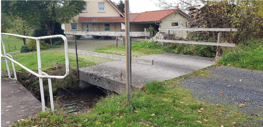
Abbildung 13: Querbauwerk über Mühlgraben, gegenüber Planbereich
