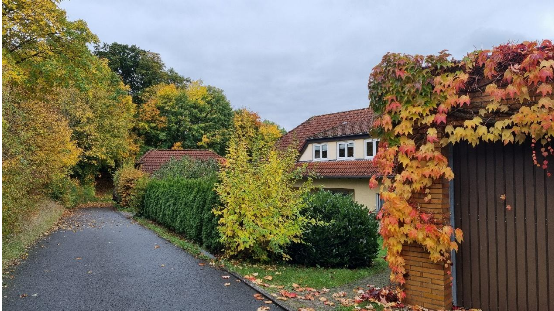
Abbildung 10: Zufahrtsweg zu Flst Nr. 54/2 und bestehende Bebauung 10.2025
