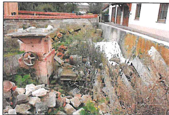
Abb. 8: Blick auf den Teil eines ruderalisierten Hausgartens im westlichen Teil des Plangebietes
