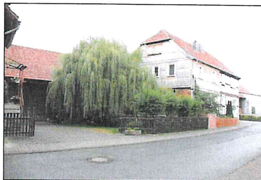
Abb. 6: Landwirtschaftliches Nutzgebäude mit Hoffläche und Trauerweide im Zentrum des Plangebietes
