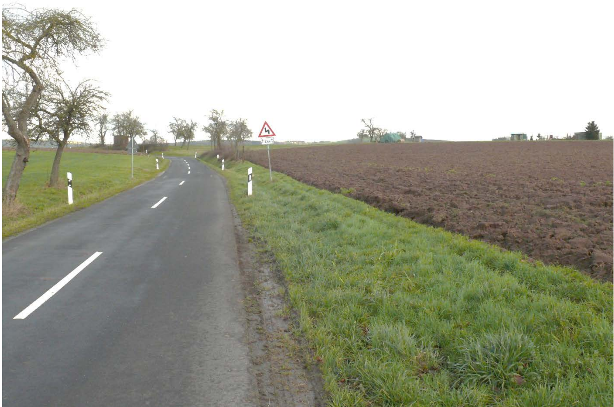
Abbildung 5: Bereich der Anbindung des Plangebietes an die K 11 „Allmuser Straße“
